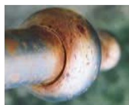
Korozija u procjepu
